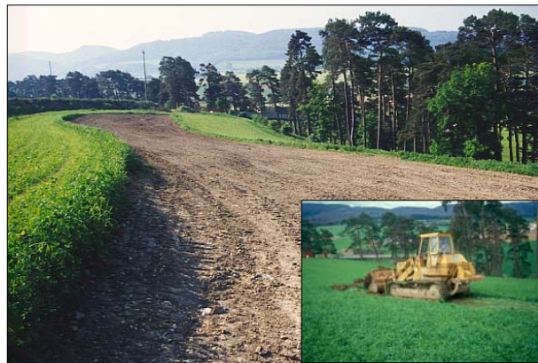
Figure 2. Terrassement de la terre végétale et état initial.
