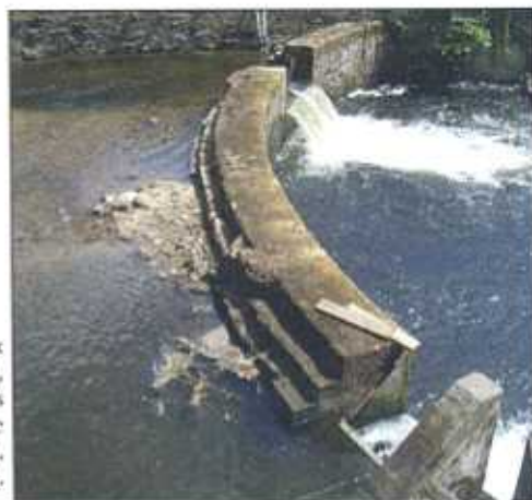
Lors des travaux de réhabilitation, la vidange des plans d'eau est un préalable incontournable. Ici, à Tulle (Corrèze).
